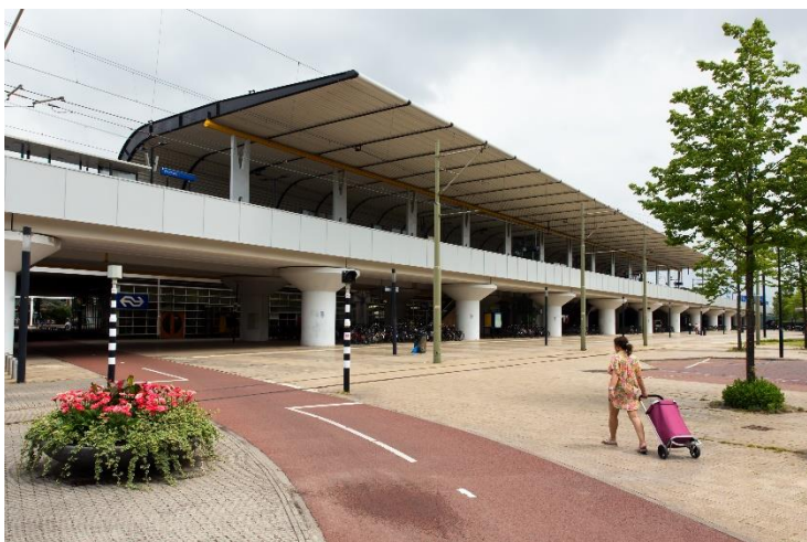
Figuur 14. Huidige situatie station Voorburg
